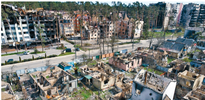
Зруйнований Ірпінь. Світлина. Весна, 2022 р.
