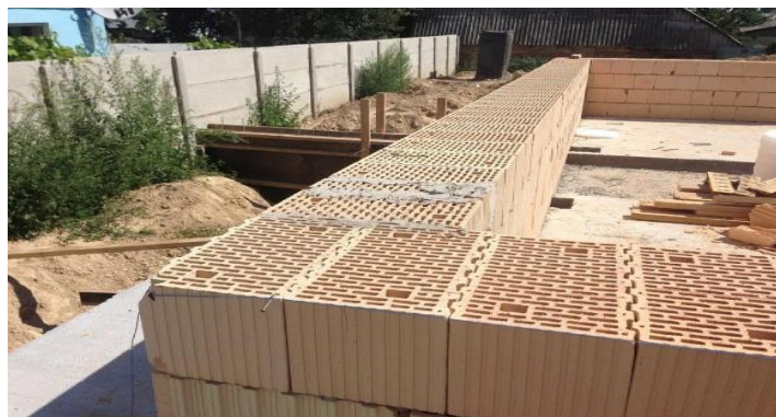
Рис. 3.8. Укладання стін з керамоблоків
