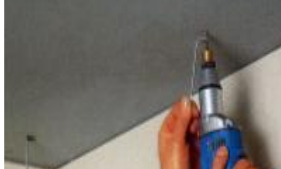
Рис. 4.10. Установка анкерного дюбеля
