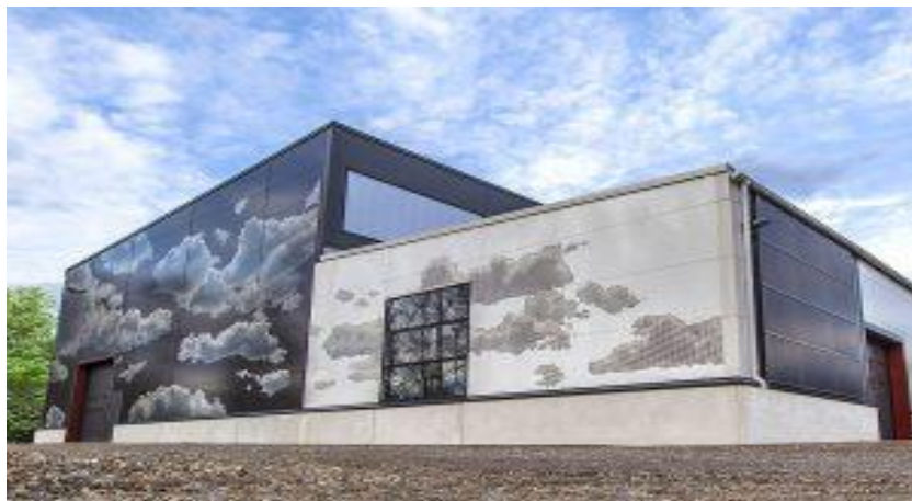
Рис. 3.1. Будівля з сендвіч-панелей
