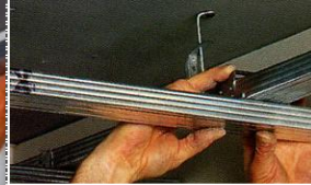
Рис. 4.13. Установка несучого профілю
