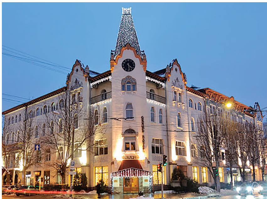
Іл. 7. Готель «Україна» (Будинок інженера Хреннікова). Дніпро
