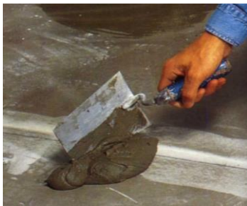
Рис.5. Нанесення клею на поверхню основи
