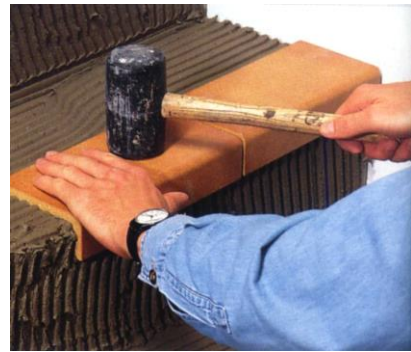
Рис.14. Укладання плитових кромки для сходинок
