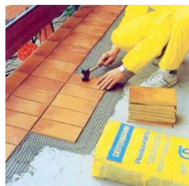
Рис.6. Приклеювання плиток клеєм Plastikol KM
