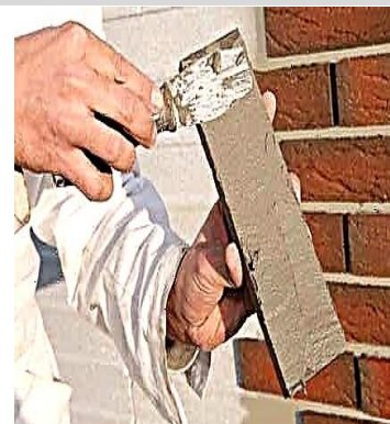
Рис. 13 Розподіл клею по плитці
