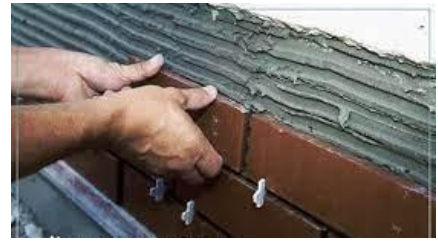
Рис. 10 Прикріплення плиток на фасаді
