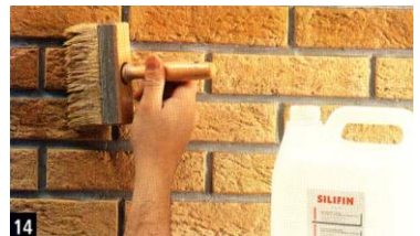
Рис.14. Обробка стін захисним засобом.
