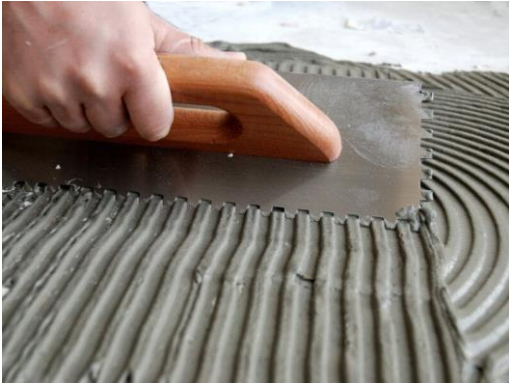
Рис.2 Укладання клейового розчину
