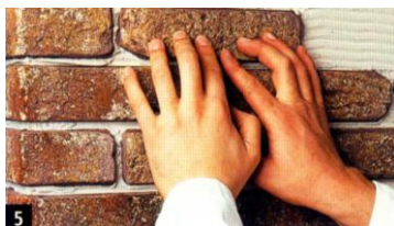
Рис.5. Прикладання плитки до стіни ковзними рухами
