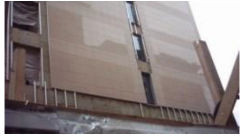
Рис.5. Загальний вигляд вентильованого фасаду
