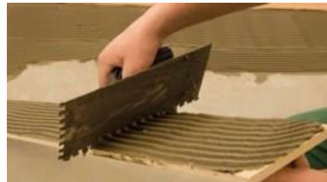
Рис 3. Намазування плитки клеєм
