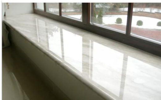
Рис.1. Влаштування підвіконних плит
