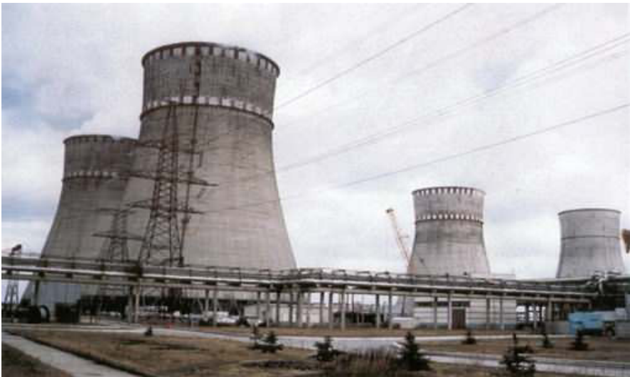
Мал. 10. Загальний вигляд атомної електростанції
