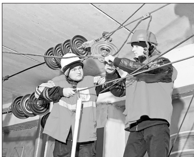
Здобувачі освіти з професії «Електромонтер контактної мережі» на навчально-практичному полігоні ДПТНЗ «Козятинське міжрегіональне вище професійне училище залізничного транспорту» під час виконання завдання «Регулювання контактної підвіски та спряження анкерних ділянок»
