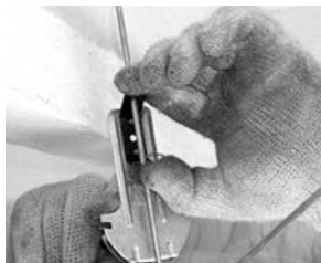
Мал. 12. Закріплення швидкого підвісу до перекриття
