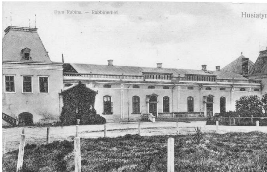
Резиденція рабина. Гусятин, Тернопільська обл., кін. XIX ст. Будівля не збереглася
