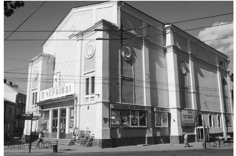
Будівля колишнього темпелю у Чернівцях, нині – кінотеатр
