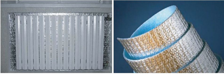
Рис. 6.10. Тепловідбивний екран із порилексу
