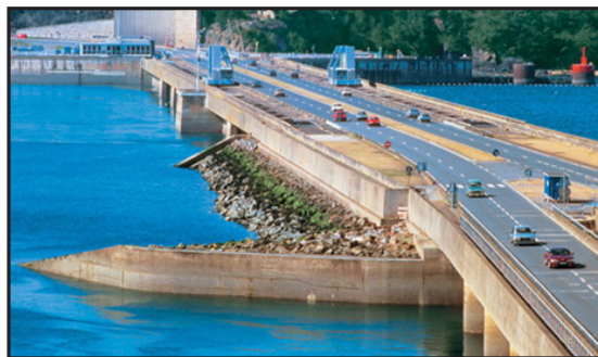
Мал. 1.39. Перша в світі припливна електростанція на річці Ранс (Франція)
